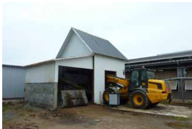
Figur 2.13. Hus bygget til separatoren.
